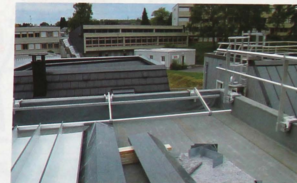
Les toits des pavillons de formation servent pour les formations à l'étanchéité sur toiture-terrasse.
