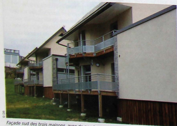
Façade sud des trois maisons, avec de nombreux volumes qui créent des masques en été pour lutter contre la surchauffe.
