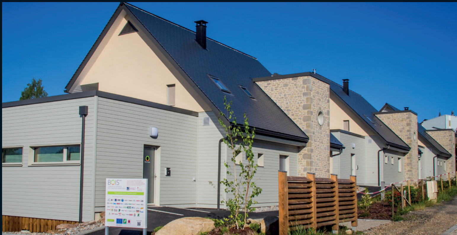
Les 3 maisons en ossature bois et à haute performance énergétique du centre BOIS PE .
